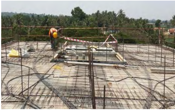
Laying conduits on slab
