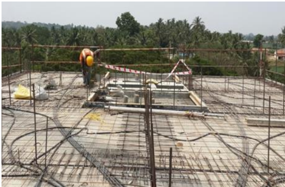
Laying conduits on slab
