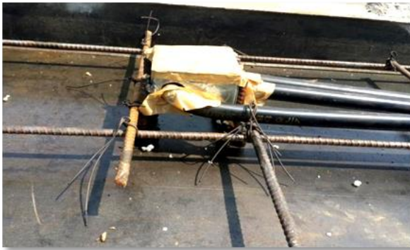
Fixing electrical conduits
